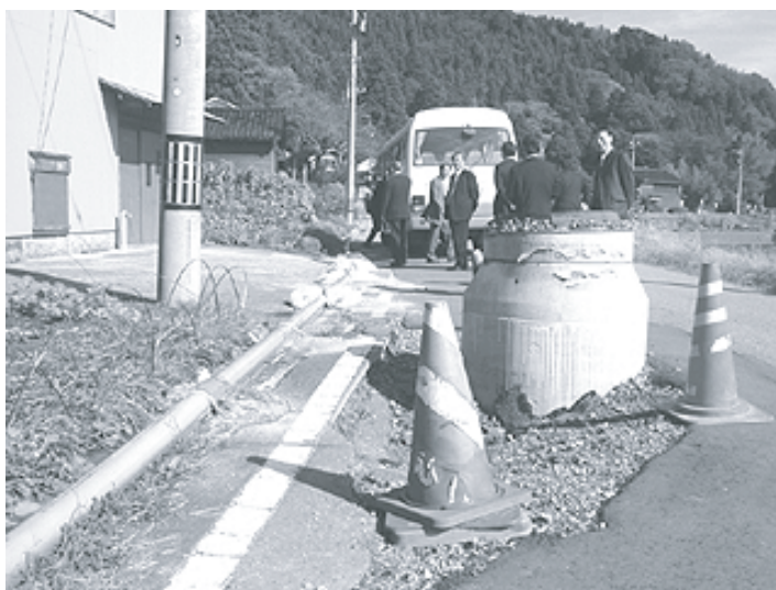
地震で浮き上がったままのマンホール
